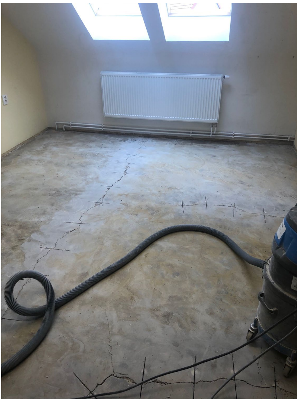
Oprava podlahy v podkroví – budova Valtická
